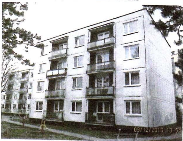
Obytný blok A2 - Zadná obvodová stena
