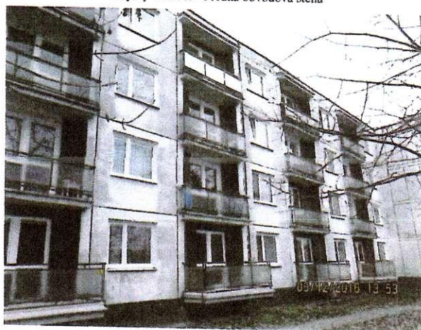
Obytný blok A1 - Zadná obvodová stena
