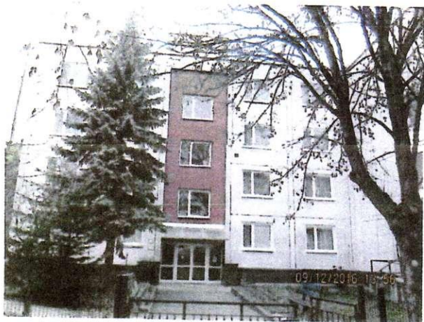
Obytný blok A2 - Predná obvodová stena
