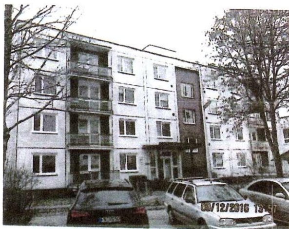
Obytný blok A1 - Predná obvodová stena
